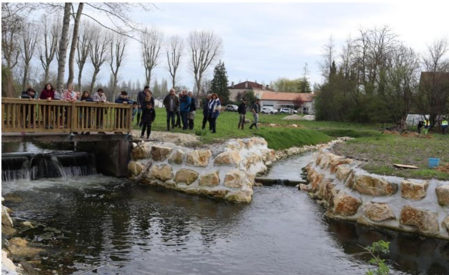
*Le syndicat a créé un bras de détournement de la Tude pour permettre à la faune de contourner le barrage.*
