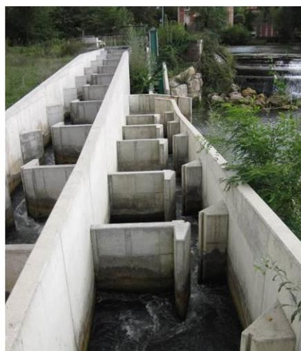
Fig. 5 : Passe à bassin (au premier plan) et rampe à brosse (au second plan) du seuil de Monfourat
