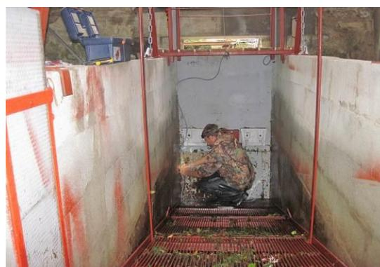
Fig. 38 : Installation de l'antenne RFID à Monfourat
