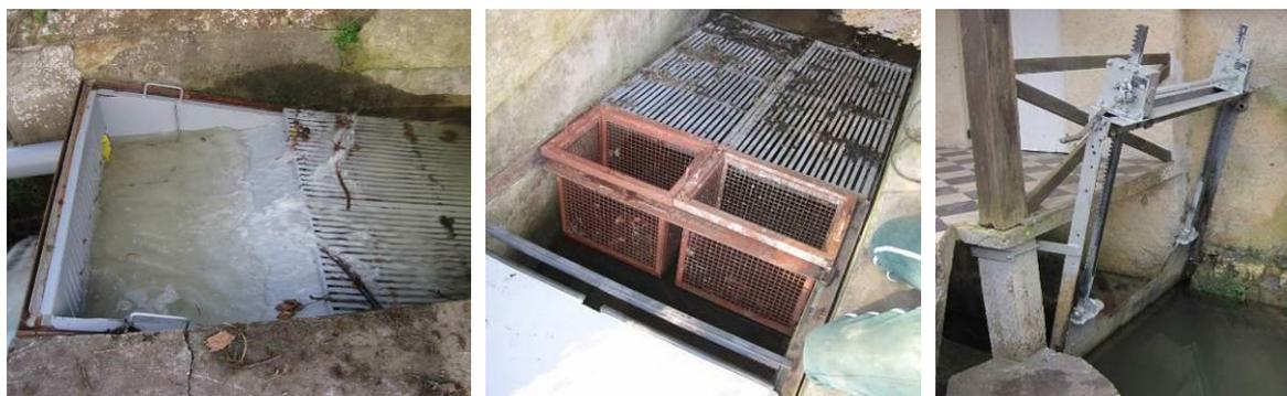
Fig. 22 : Rénamon en configuration classique (à g.), avec paniers (au centre) et le vannage (à d.)
