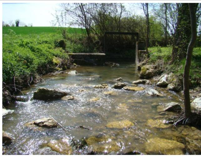
Après travaux aval de l'ouvrage rechargement pour diminuer les pentes et diversifier les écoulements
