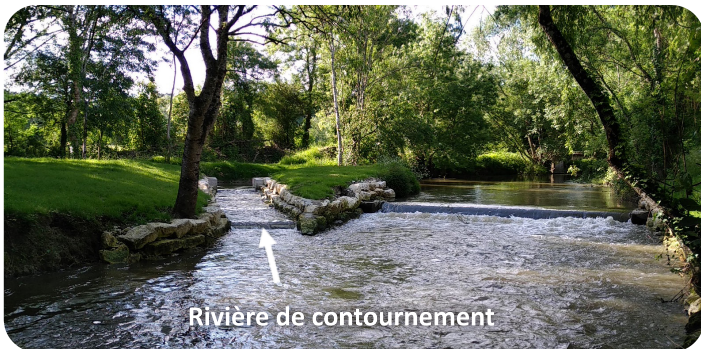
Rivière de contournement vue par l'aval sur la Tude aval, au lieu-dit « le Bertaud » (OP15), sur les communes de Saint-Avit et Chalais.
