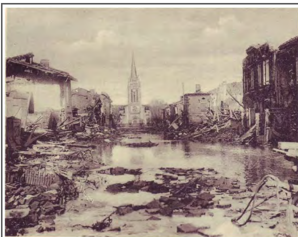
Illustration 16: Village de Reynies après le passage de la crue du Tarn de mars 1930 (source : DDT 82)
