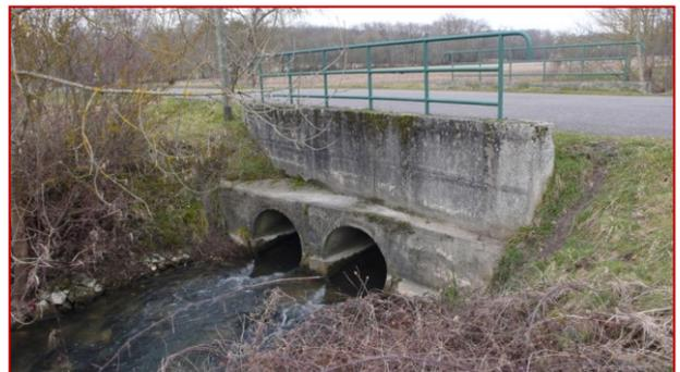
Les ouvrages de faible largeur ou sous-capacitaires (buses, etc.) peuvent également favoriser la formation d'embâcles, notamment sur les affluents. C'est aussi le cas des seuils « à guillotines ».
