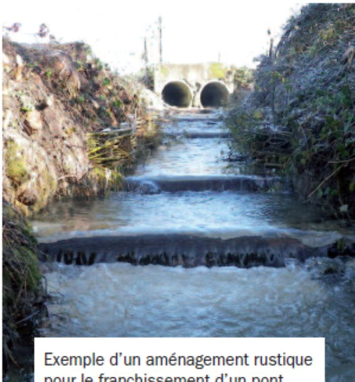
Exemple d'un aménagement rustique pour le franchissement d'un pont buse sur un affluent de la Tude
