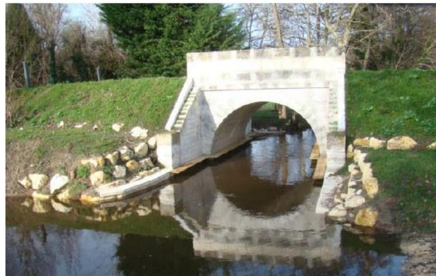
Après travaux vue par l'aval du pont. Maçonneries restaurées par le CG 16 avec pose de passages à visons
