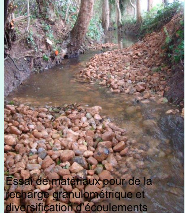
Essai de matériaux pour de la recharge granulométrique et diversification d'écoulements
