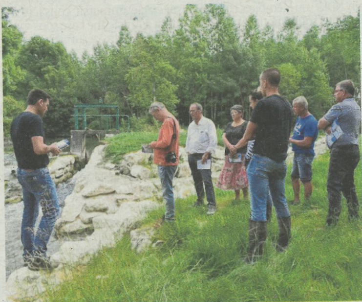
À gauche Gaël Pannetier expliquant le chantier de rénovation de la Tude, au lieu dit du Pavillon, commune de Bazac. PHOTO TH. M.
