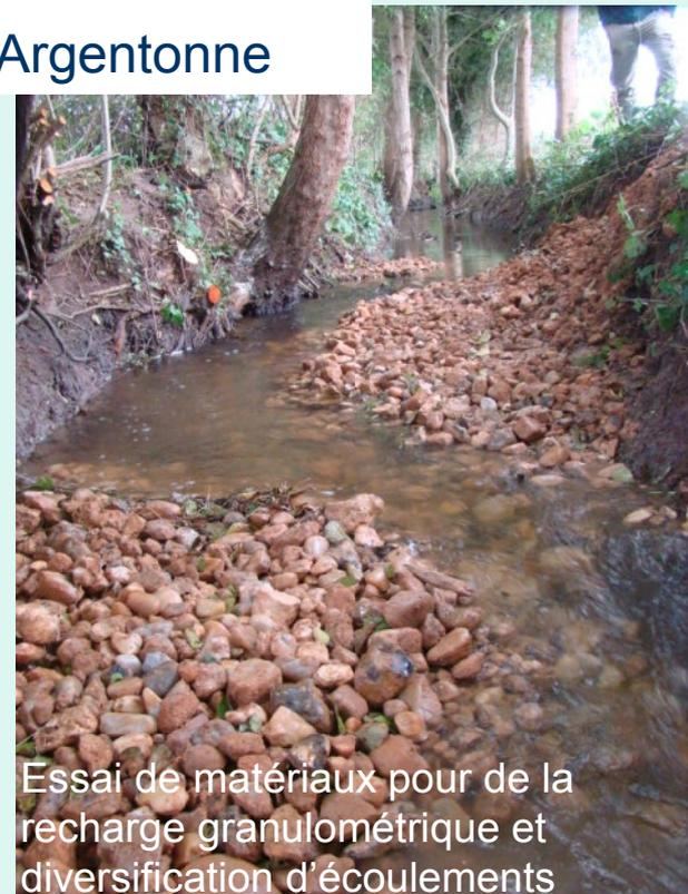
Essai de matériaux pour de la recharge granulométrique et diversification d'écoulements
