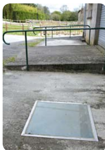
Installation d'un puits de lumière sécurisé sur la Sonnette ici souterraine (SIAH Son Sonnette).
