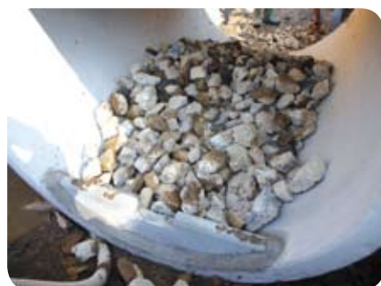
Installation de barrettes échanrées en fond de buse (PETR Monts et Barrages).
